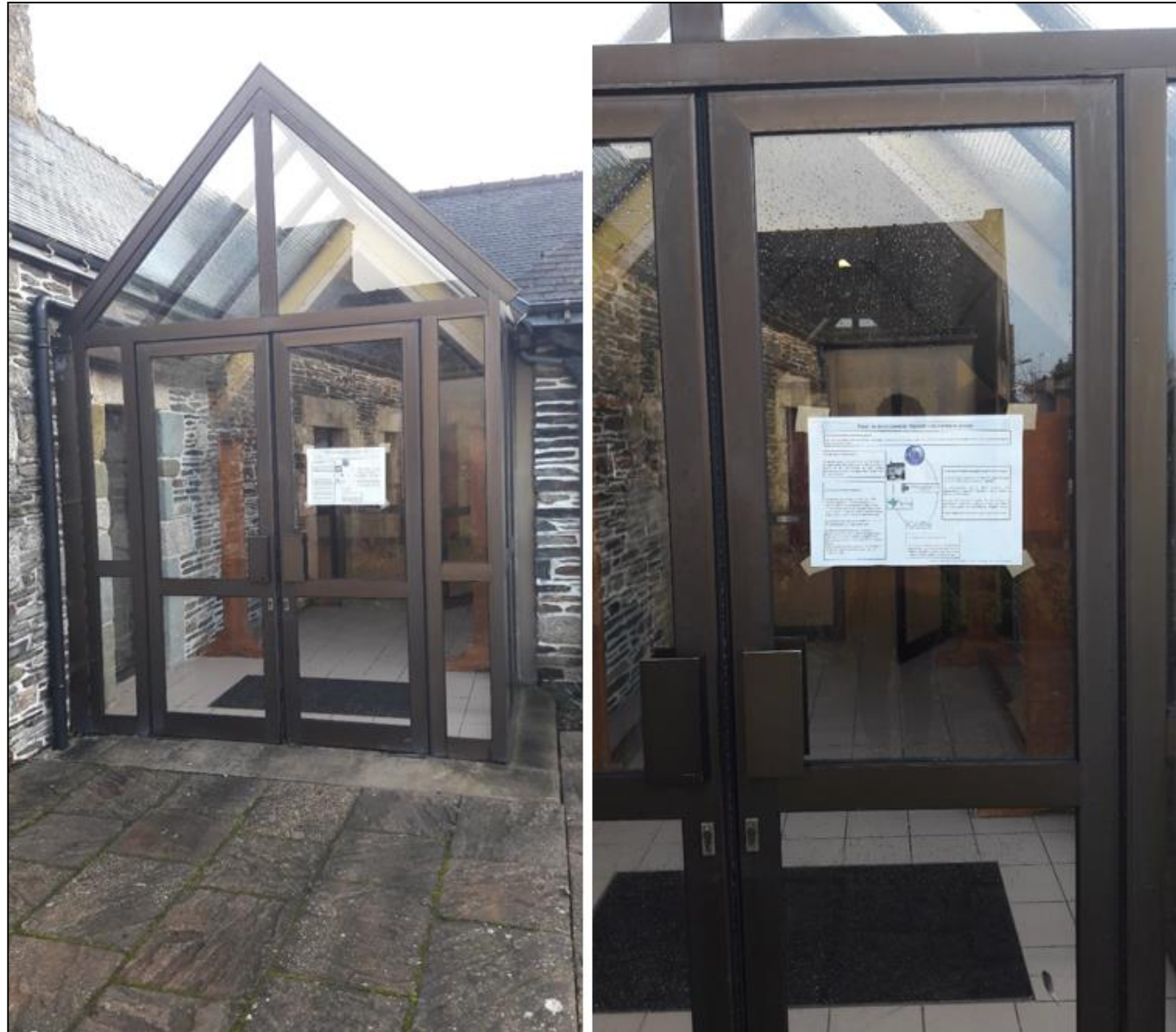
Photo 1 : Entrée de la salle polyvalente de Saint-Connec, au niveau de la mairie, février 2020 (Source : Parc Eolien COTES ARMOR 1)
